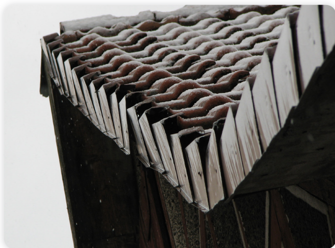
Befestigung mit Nägeln
