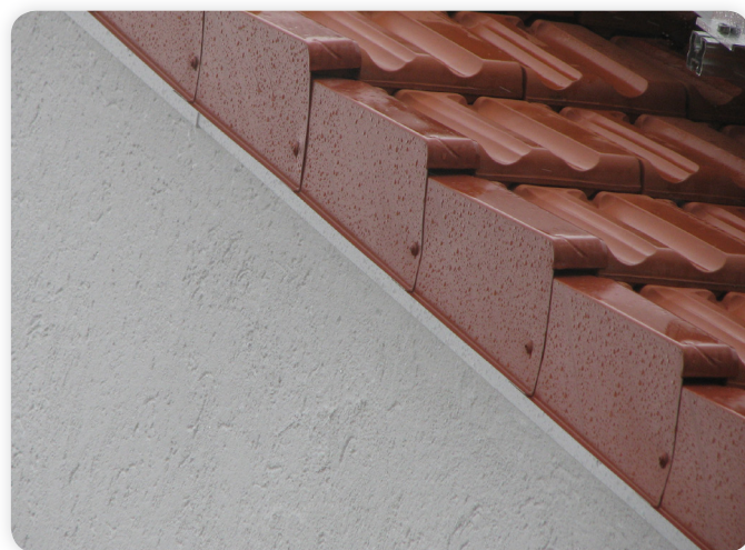
Fachgerechte Befestigung mit Spenglerschrauben
